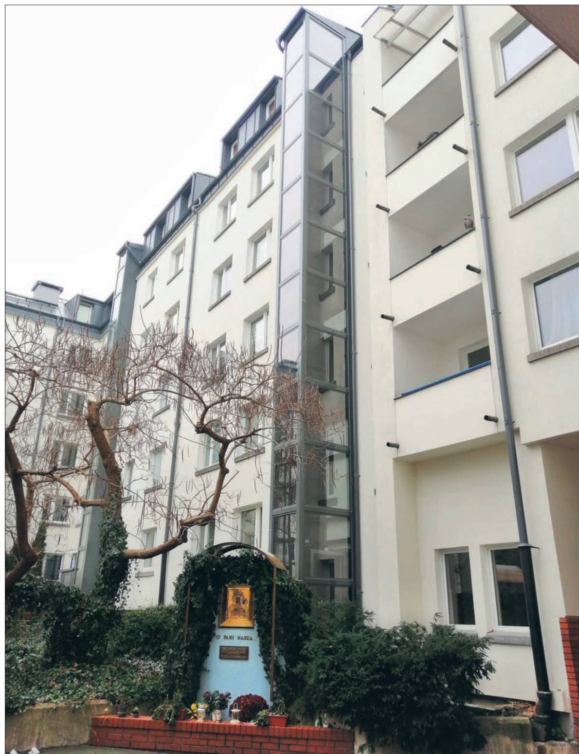
Transport pionowy zrealizowany przez Spółdzielnię Mieszkaniową „Idealne Mieszkanie Centrum” w budynku przy ulicy Hożej 43/49.
