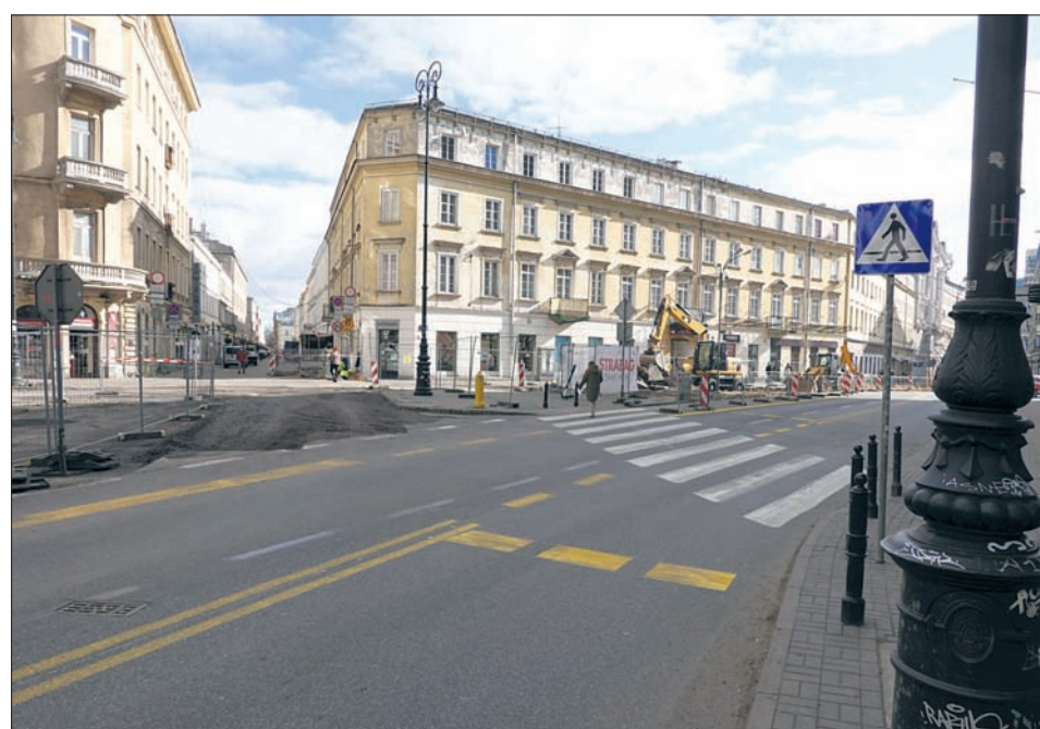
Plac Pięciu Rogów w trakcie przebudowy.
