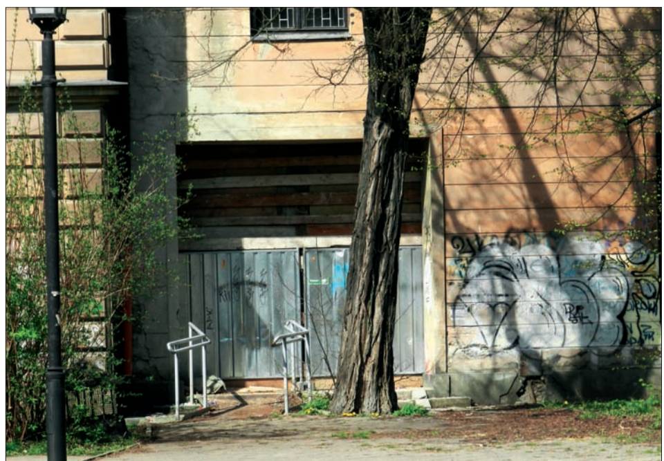
Zabite deskami przejście pod łącznikiem Pałacu Zamoyskich.
